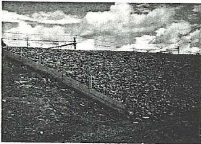
Tätning och täckning av kreosotförorenad jord i Katrineholm.
